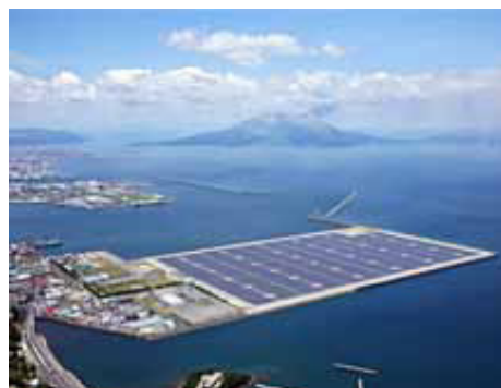
鹿児島七ツ島メガソーラー発電所
