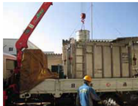
PCB搬出作業（鹿児島川内工場）
