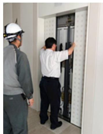
エレベーター救出訓練（本社）
