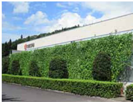
グリーンカーテン (福島棚倉工場)
