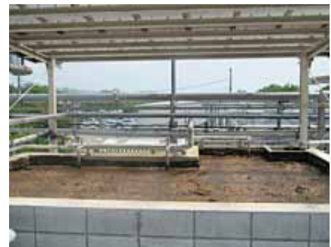
研削廃液曝気槽（好気性生物による有機物分解）
